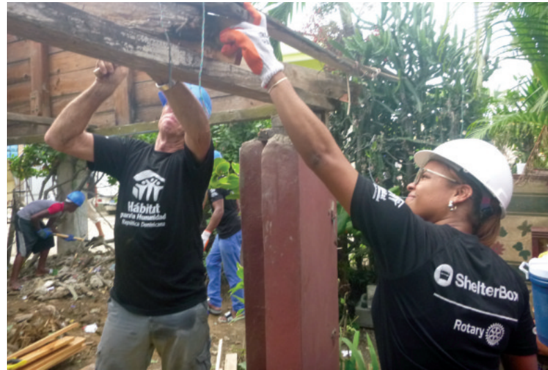
ShelterBox, Rotary und Habitat for Humanity erstellen zusammen Unterkünfte für Familien in der Dominikanischen Republik.
